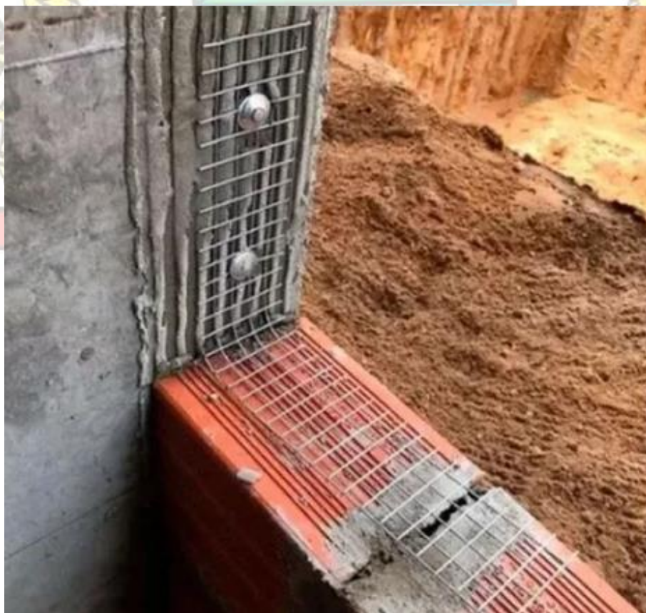
Imagem 1: tela a ser utilizada para reforço onde há trincos, fissuras.
