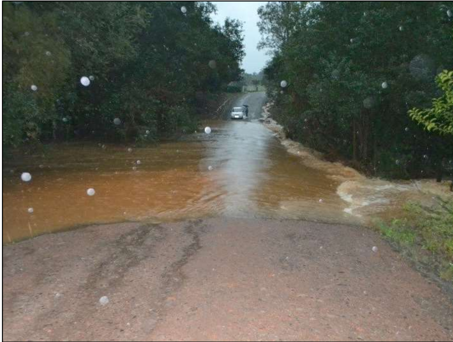
Figura 181 – Inundação ocorrida no local em 15 de julho de 2015.
