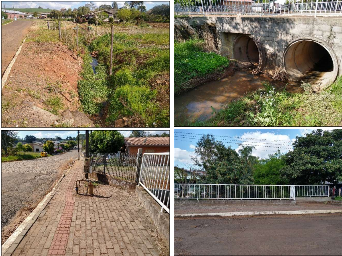
Figura 81 – Situação atual do ponto de atenção 02, localizado onde a rua Valdemar Stieler atravessa o Lajeado do Tigre.
