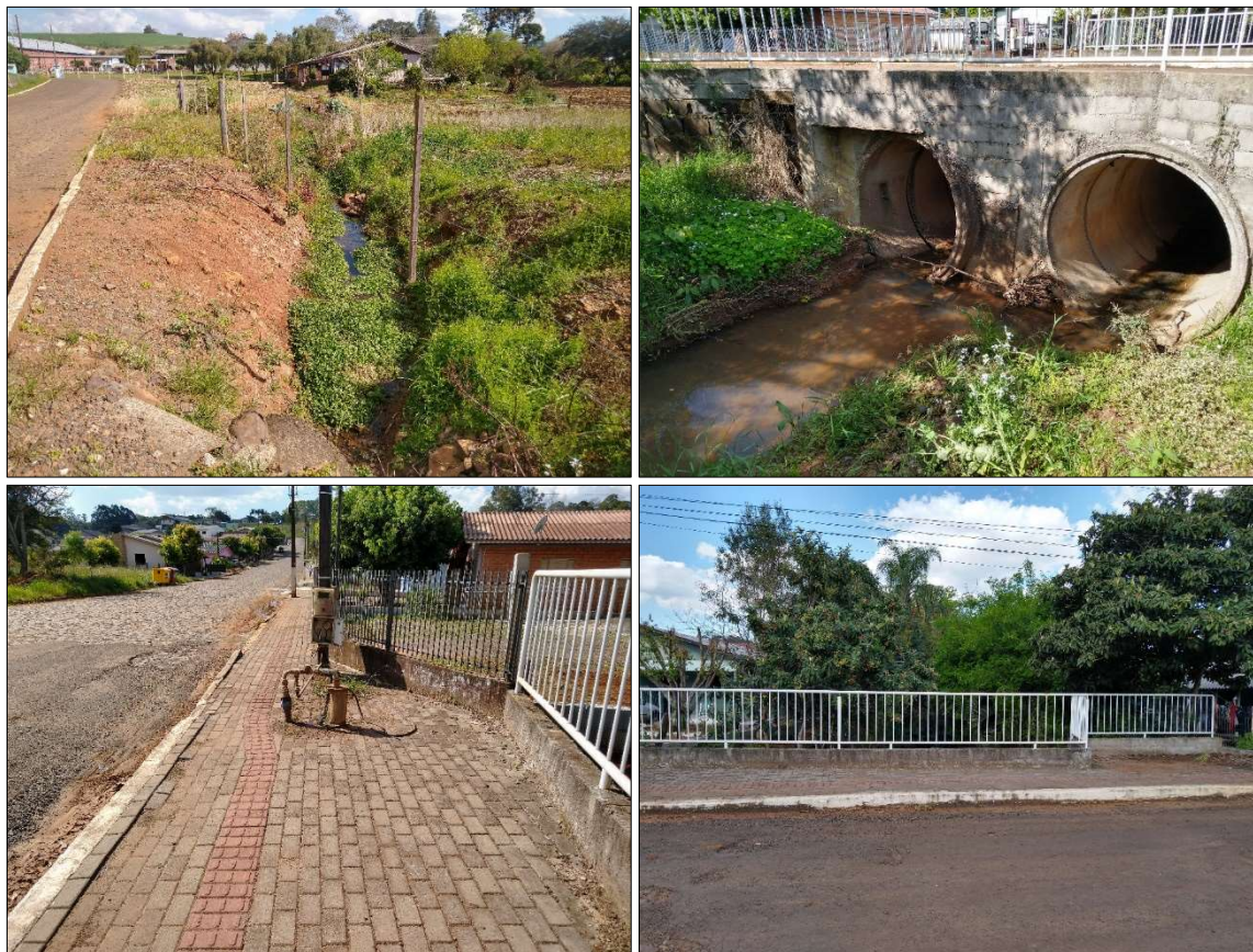
Figura 176 – Situação atual do ponto de atenção 02, localizado onde a rua Valdemar Stieler atravessa o Lajeado do Tigre.
