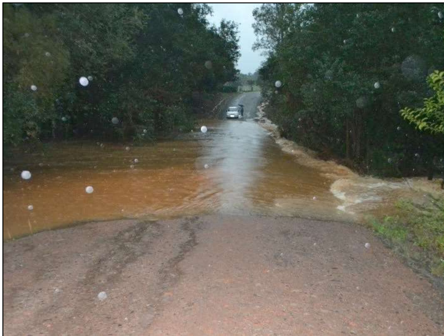
Figura 86 – Inundação ocorrida no local em 15 de julho de 2015.
