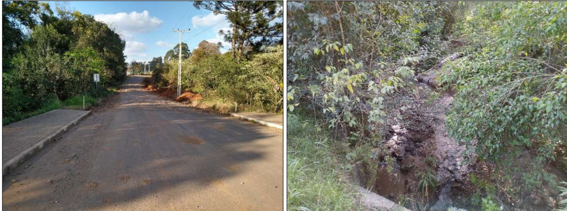
Figura 180 – Situação atual do ponto de atenção 04.
