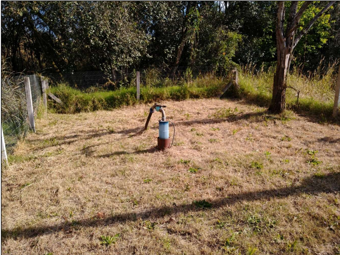
Figura 14 – Poço tubular profundo observado na área urbana do município e que capta água do aquífero fraturado.
