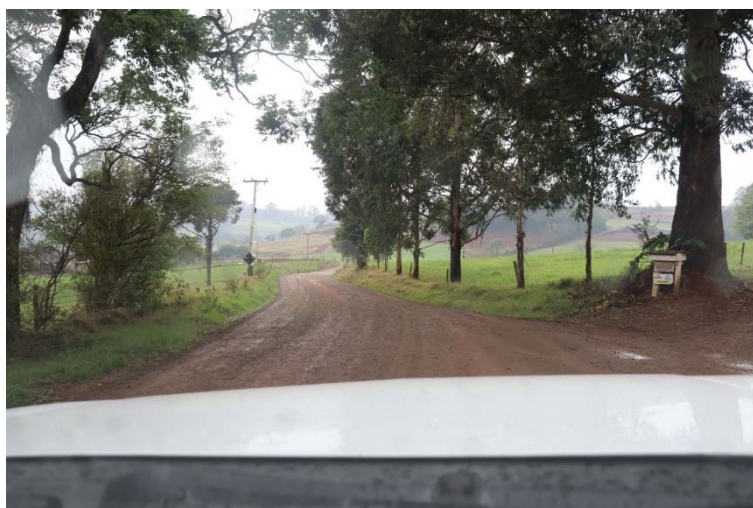
Figura 10 - Estaca 0+200: caracterização da via existente.
