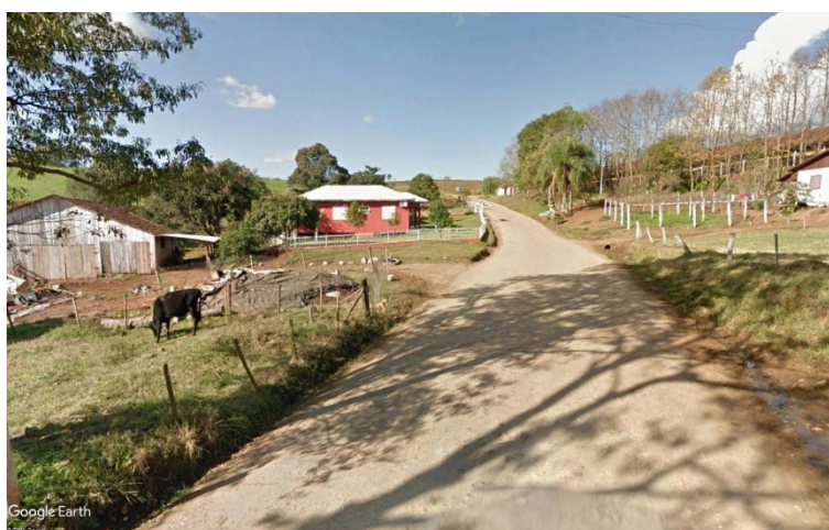
Figura 12 - Estaca 1+500: caracterização da via existente.
