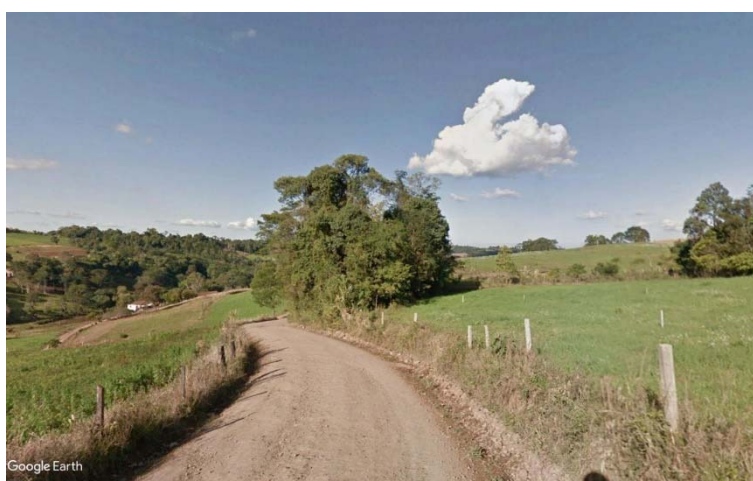
Figura 13 - Estaca 1+800: caracterização da via existente.
