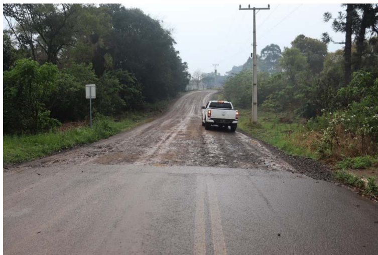
Figura 9 - Estaca 0: caracterização da via existente.
