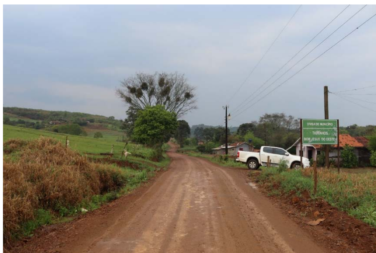
Figura 15 - Estaca 2+800: caracterização da via existente.
